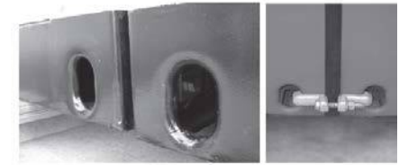
Bild 4 Außen- und Wandverbindung der Module
