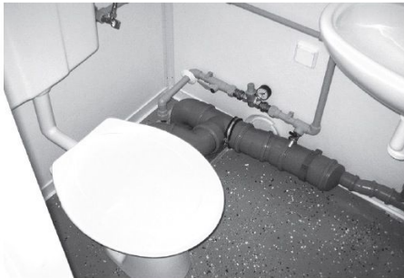
Bild 12 Installation im Boden
